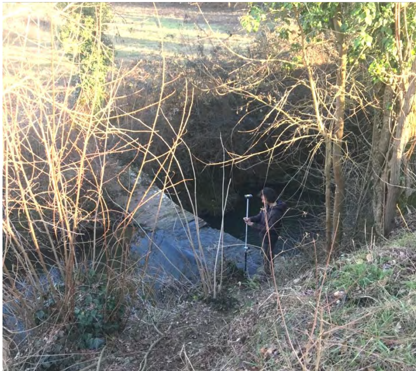
Figura 3 – fase operativa di rilievo in alveo
