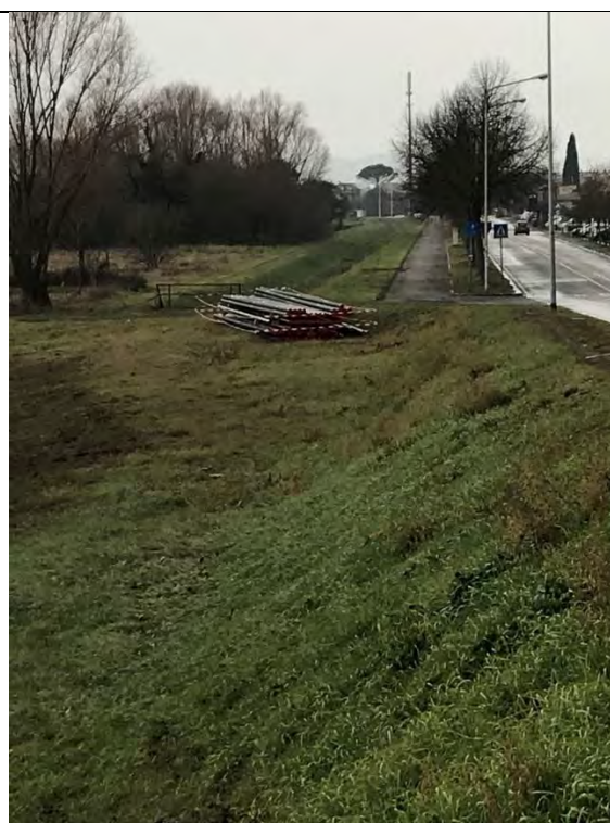
Panoramica canale a valle
