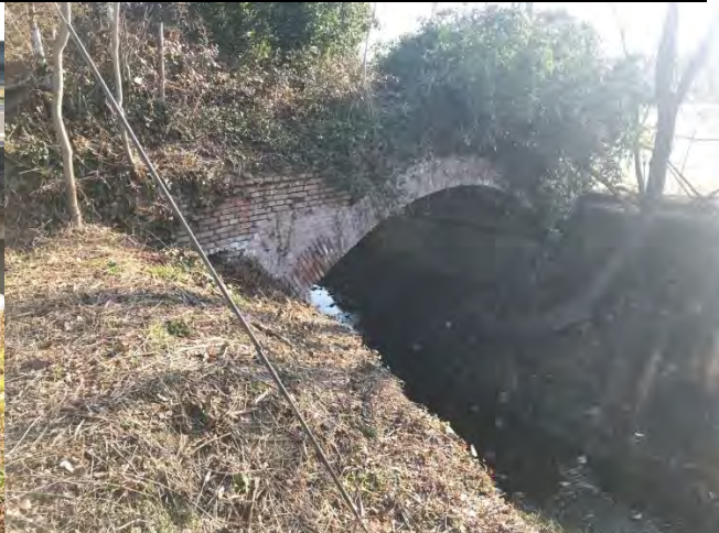
Preesistente attraversamento a monte, in disuso
