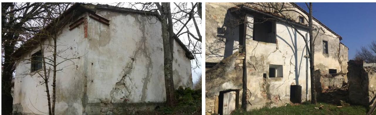
Figura 44: Settore di Monte sopra Rondine: i movimenti di scivolamento rotazionale che interessano in diverse zone le coltri colluvio – alluvionali plio-quadernarie, hanno interessato anche la porzione superiore del centro abitato con evidenze di crepe e fratture negli edifici storici e recenti, ad indicare un fenomeno lento e tutt'oggi attivo.
