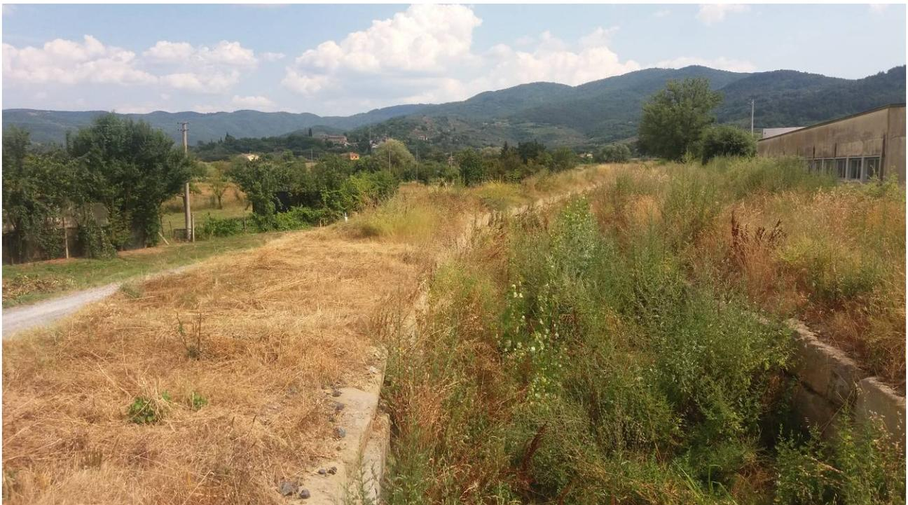
Figura 22: Torrente Sellina. Si tratta di un sistema fluviale con alveo pensile sopraelevato rispetto alla piana circostante e con argini artificiali per il contenimento dei fenomeni di esondazione.
