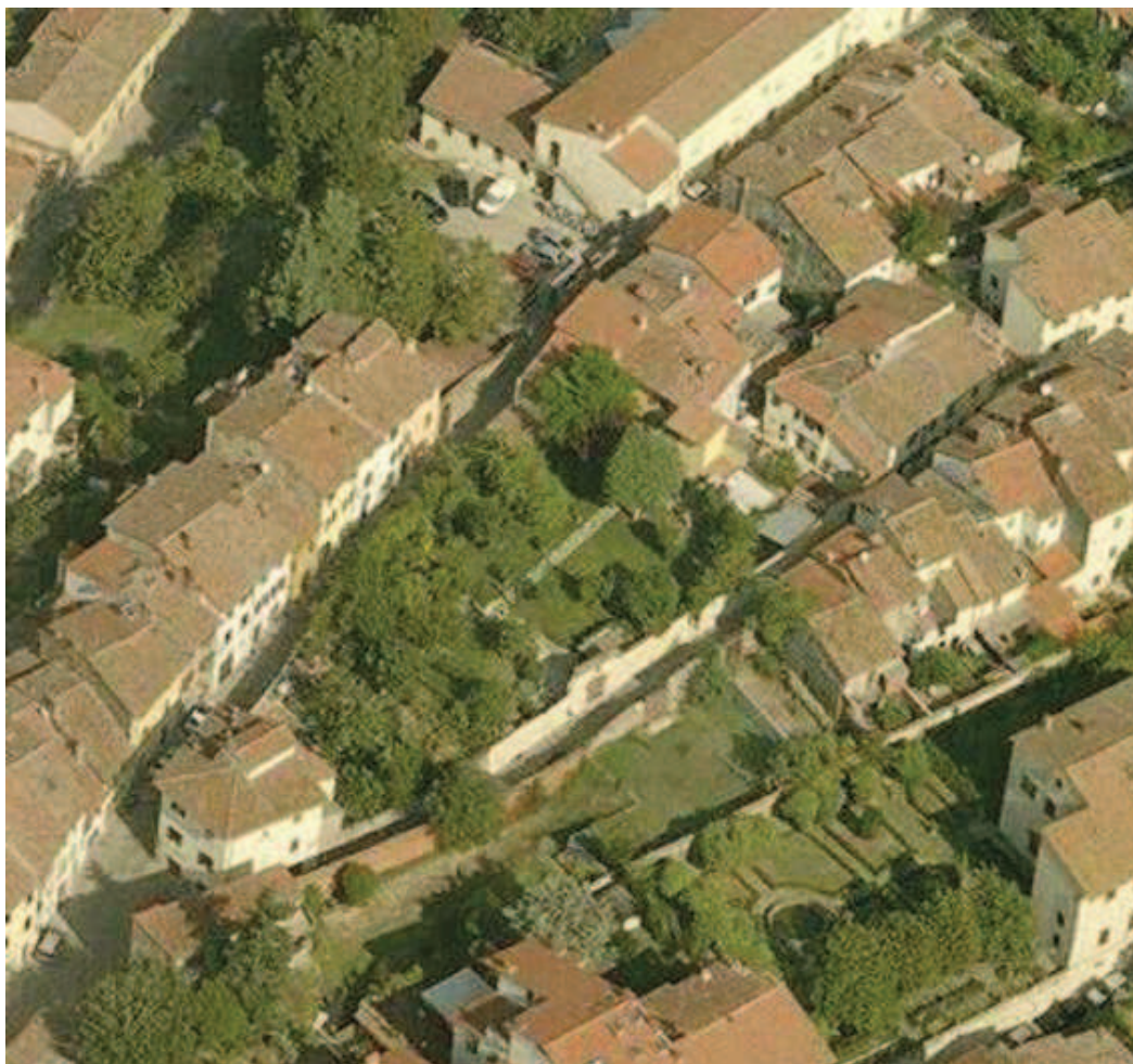
vista dall'alto fronte sud
