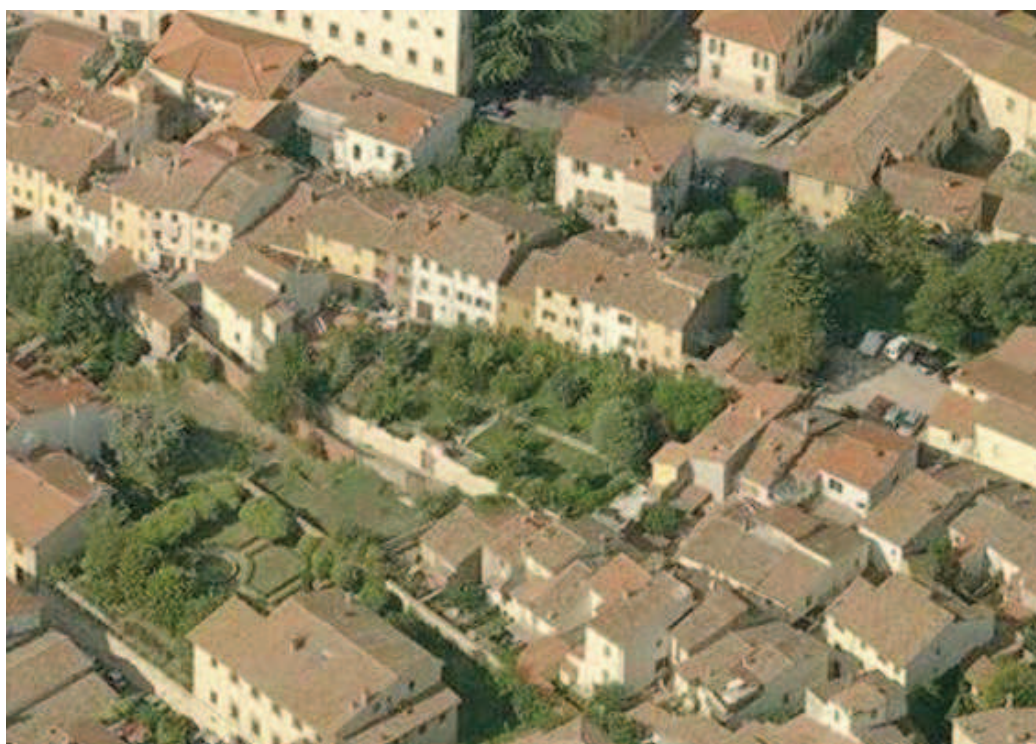
vista dall'alto fronte est
