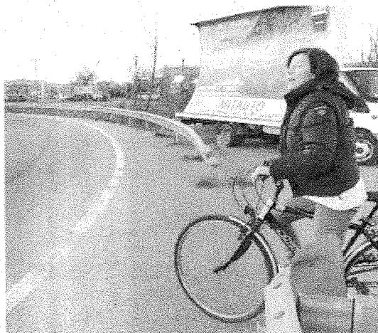
IL PUNTO DI PARTENZA La rotonda sulla Casentinese: da qui inizierà nel 2018 il prolungamento della tangenziale fino a via Buonconte
