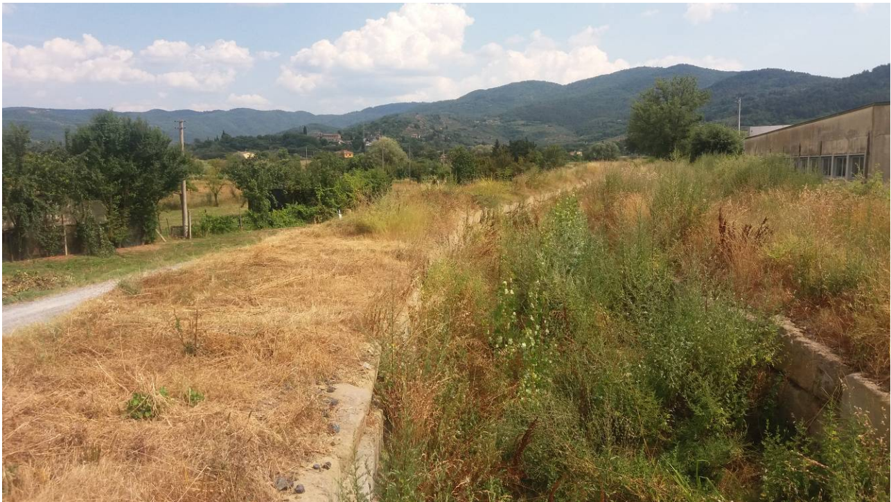
Figura 5: Nelle aree di Alta Pianura sono spesso presenti sistemi fluviali con alveo pensile sopraelevato rispetto alla piana circostante e con argini artificiali finalizzati al contenimento dei fenomeni di esondazione. Il caso del Torrente Sellina.
