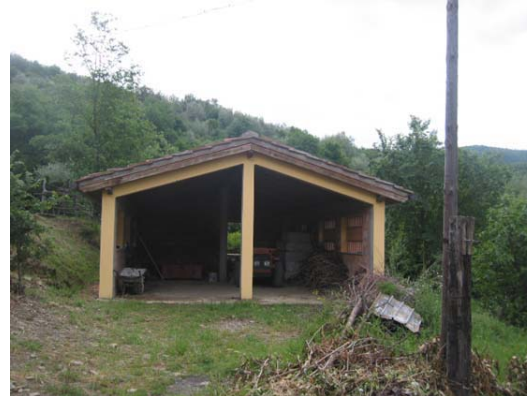
CELLAIO A028 E. 5 F. 134
