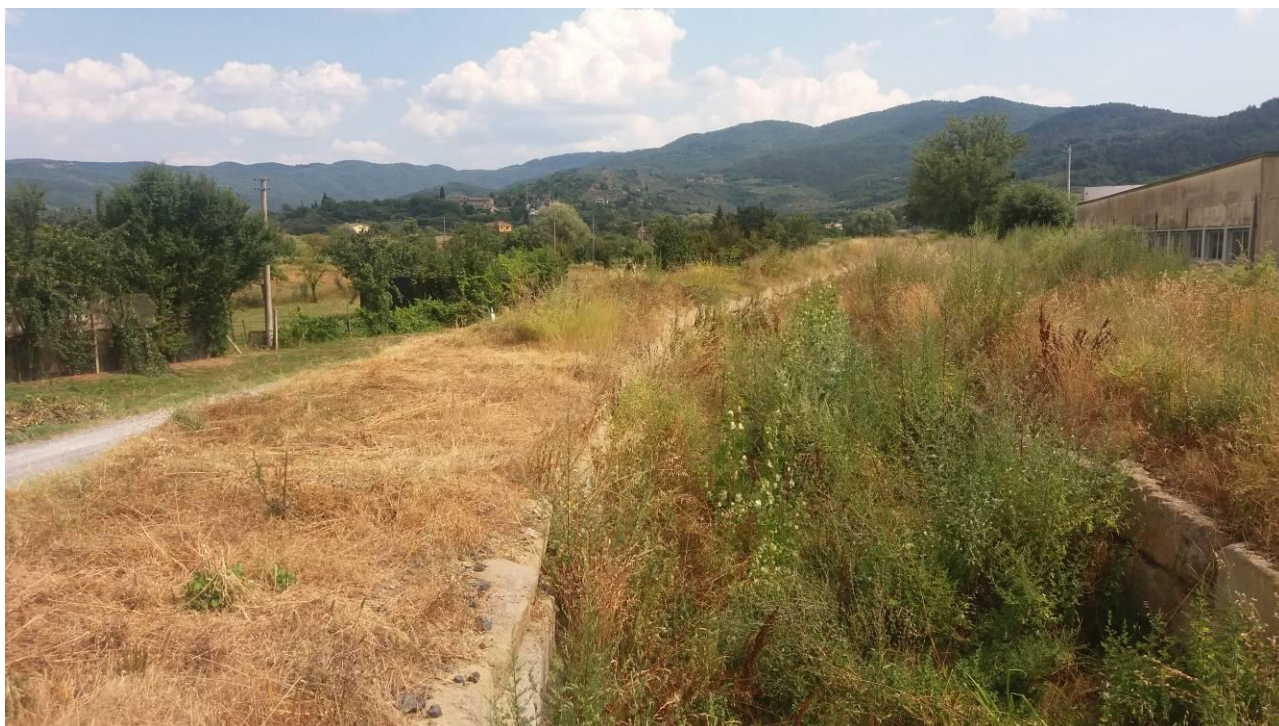
Figura 5: Nelle aree di Alta Pianura sono spesso presenti sistemi fluviali con alveo pensile sopraelevato rispetto alla piana circostante e con argini artificiali finalizzati al contenimento dei fenomeni di esondazione. Il caso del Torrente Sellina.
