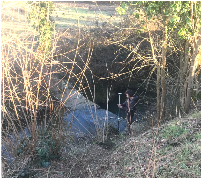
Figura 3 – fase operativa di rilievo in alveo
