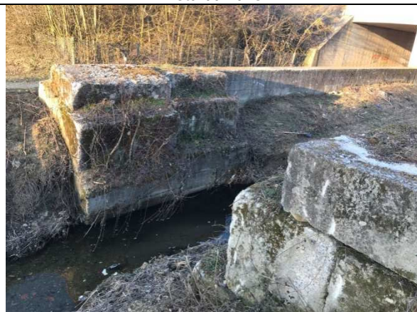
Rivestimento spondale a valle
