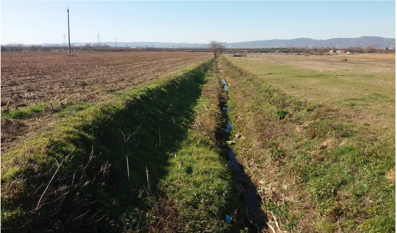
Figura 27: Rio di S. Antonio, canale sub rettilineo che drena la piana colluvio-alluvionale per poi connettersi al Rio dell'Olmo e al Canale Maestro. Si tratta di un sistema fluviale in moderata colmata alluvionale.
