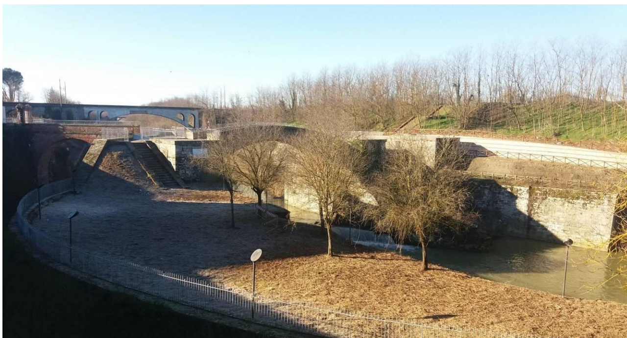
Figura 20: Chiassa dei Monaci nel tratto terminale del Canale Maestro.
