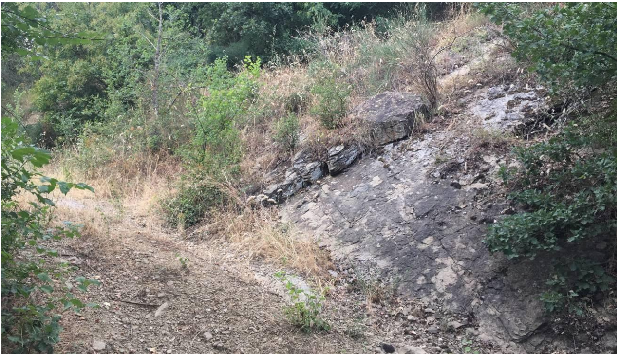
Figura 39: versante a franapoggio con superficie di strato soggetto a movimenti di scivolamento planare di blocchi di roccia
