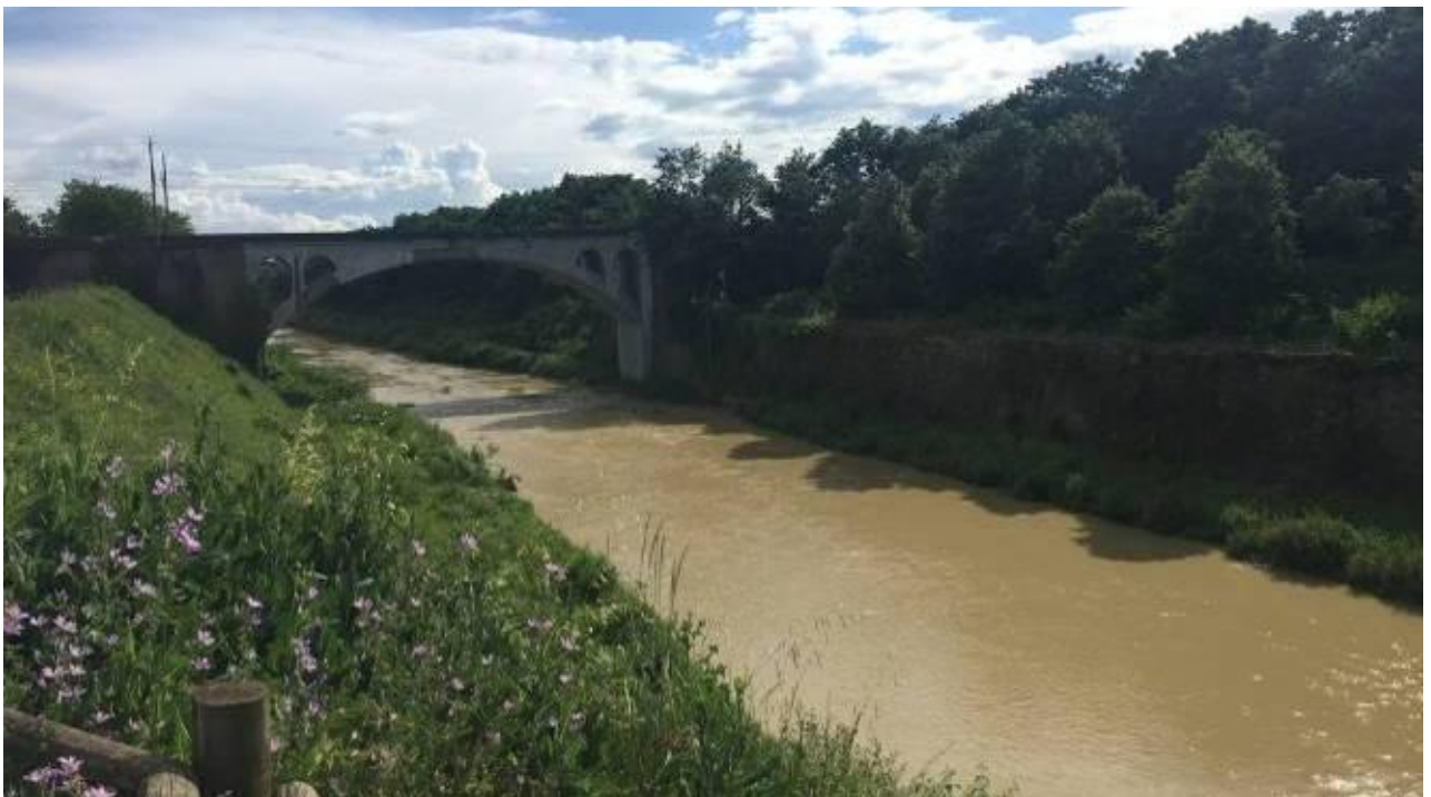
Figura 47: tratto terminale del Canal Maestro, con i ripidi versanti potenzialmente soggetti a fenomeni gravitativi connessi con le dinamiche fluviali lungo le sponde.
