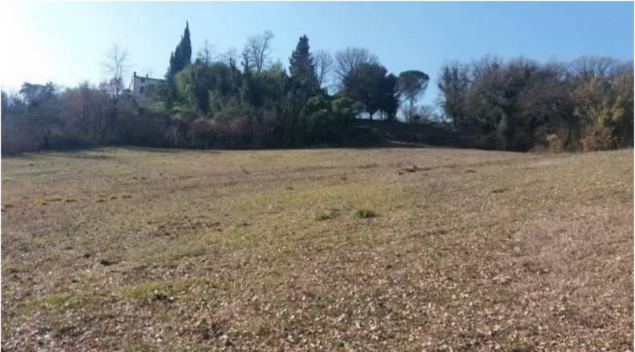
Figura 18: Settore di Monte sopra Rondine: superficie colluvio-alluvionale interessata da movimenti di scivolamento rotazionale indotti dallo scalzamento al piede della ripa d'erosione fluviale del Canale Maestro-Arno.
