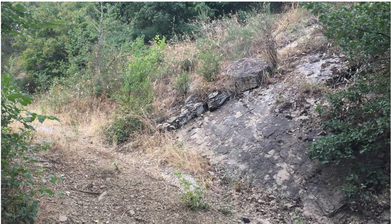
Figura 15: versante a franapoggio con superficie di strato soggetto a movimenti di scivolamento planare di blocchi di roccia
