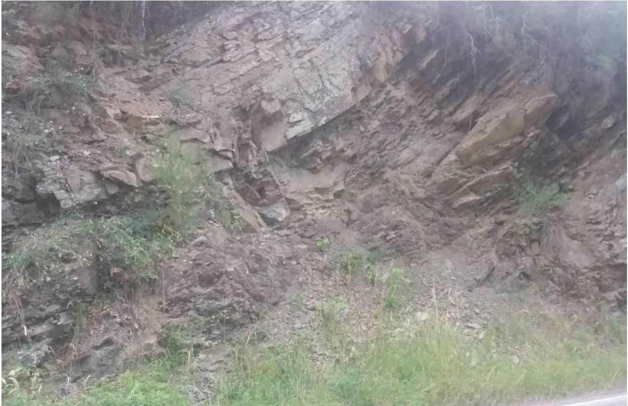
Figura 14: scarpata rocciosa a reggipoggio su un taglio stradale lungo la SP Palazzo del Pero (Loc. Molin Nuovo), scolpita su rocce riferibili al Membro arenaceo pelitico - FAL3 – dell'Unità di M. Cervarola. In tali situazioni sono possibili movimenti franosi di crollo delle porzioni maggiormente fratturate dell'ammasso roccioso
