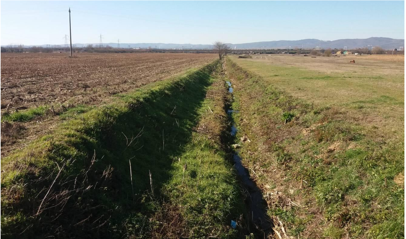
Figura 11: Rio di S. Antonio, canale sub rettilineo che drena la piana colluvio-alluvionale per poi connettersi al Rio dell'Olmo e al Canale Maestro. Si tratta di un sistema fluviale in moderata colmata alluvionale
