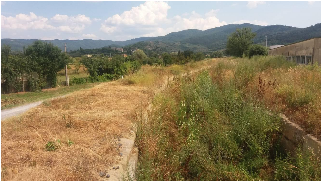
Figura 9: Torrente Sellina. Si tratta di un sistema fluviale con alveo pensile sopraelevato rispetto alla piana circostante e con argini artificiali per il contenimento dei fenomeni di esondazione.
