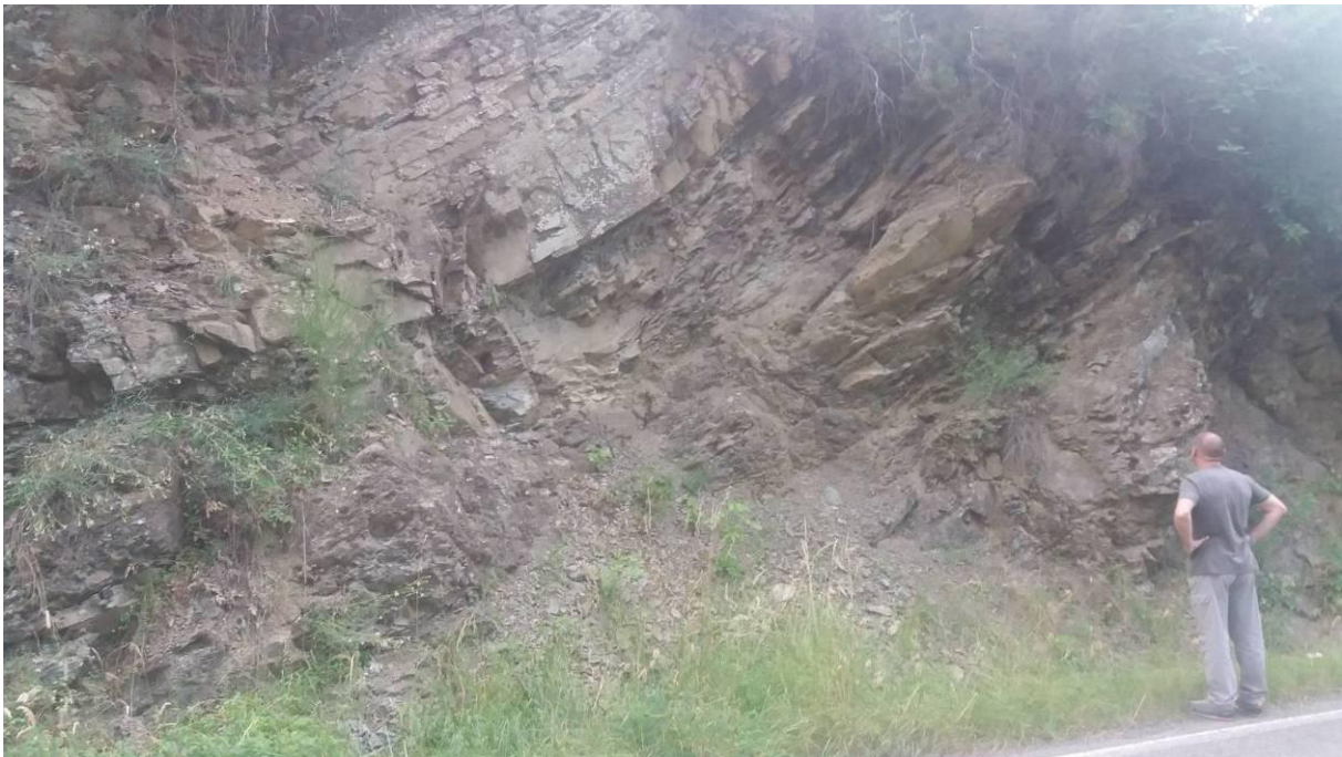
Figura 8: scarpata su un taglio stradale, scolpita sulle formazioni pelitiche, con movimenti franosi attivi - Molin Bianco (Palazzo del Pero).
