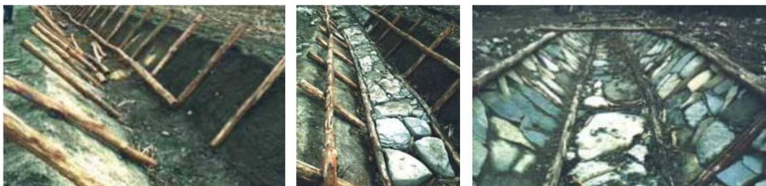
Figura 2: Fasi costruttive di una canaletta in legname e pietrame
