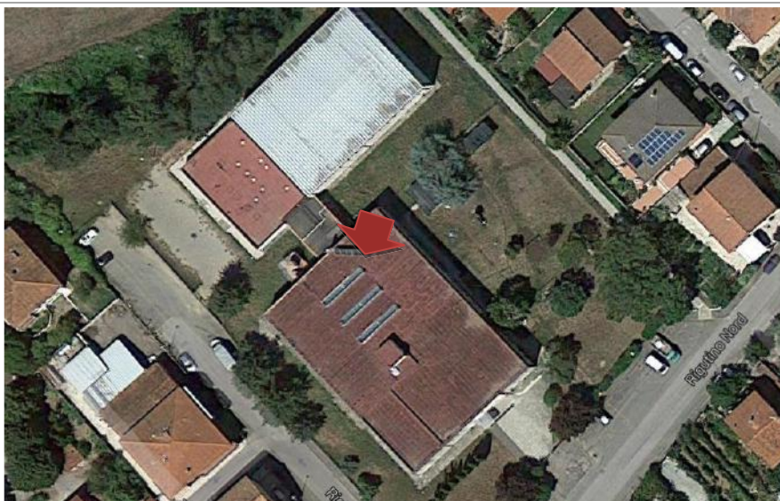
Figura 32 - Impianto solare termico Scuola media Rigutino (Fonte: Google Maps).
