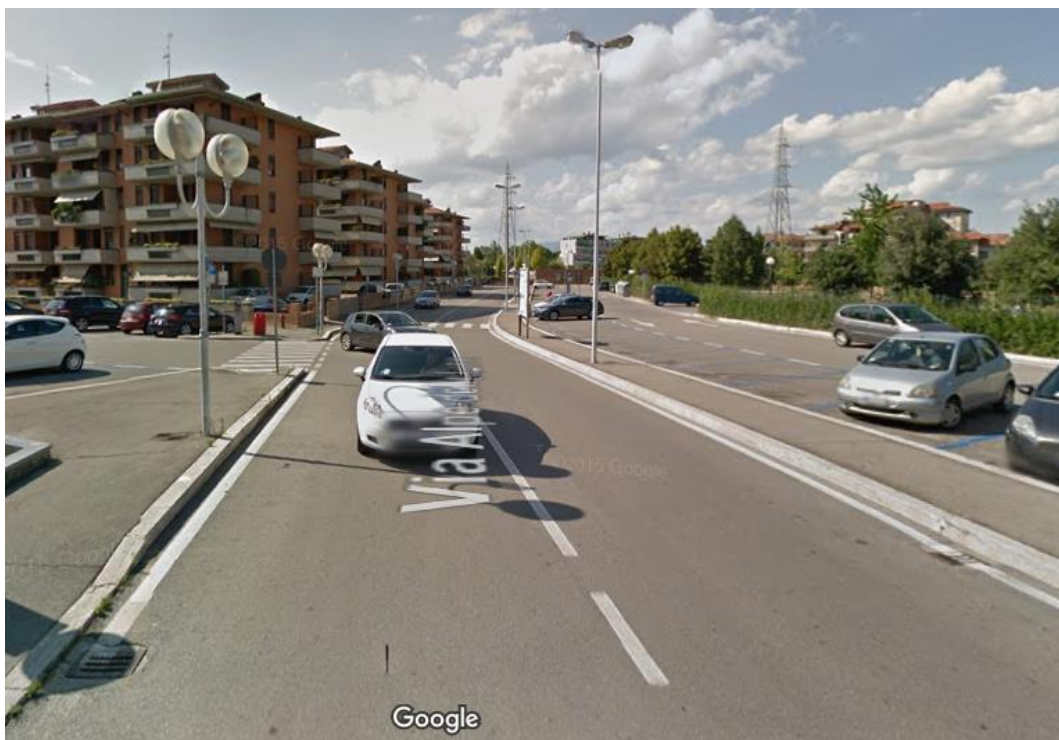
Figura 16 - Vista corpi illuminanti stradali in via Montefalco (Street View - Google).
