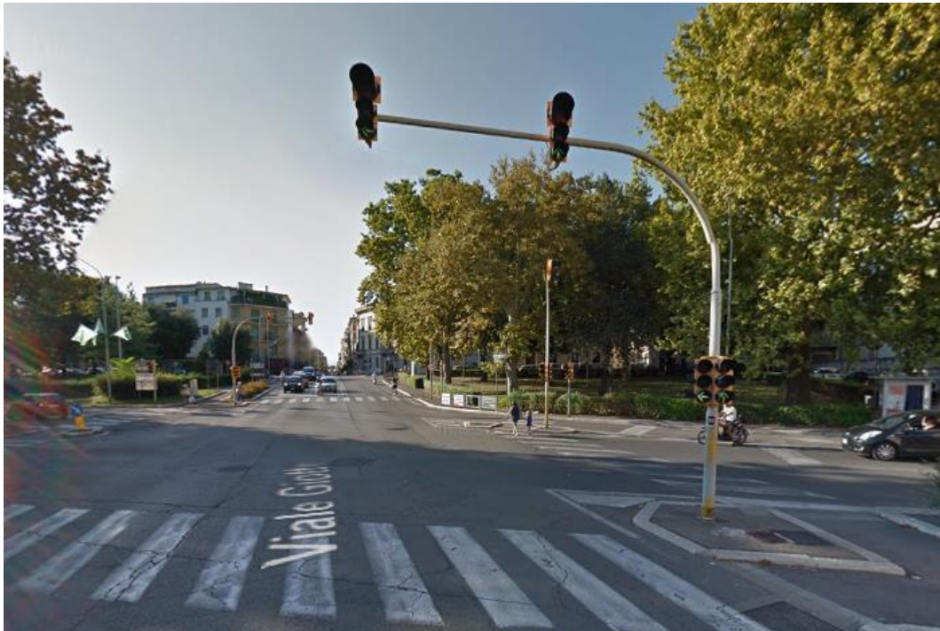
Figura 19 - Vista impianto semaforico in Viale Giotto (Street View - Google).
